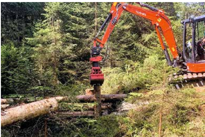
Baggerarbeiten im Moor- und Bau eines stammholzarmierten Dammes.
