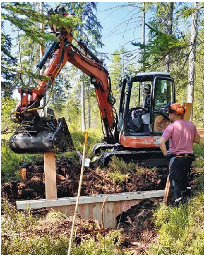
Bau der Spundwand eines Holzdammes.
