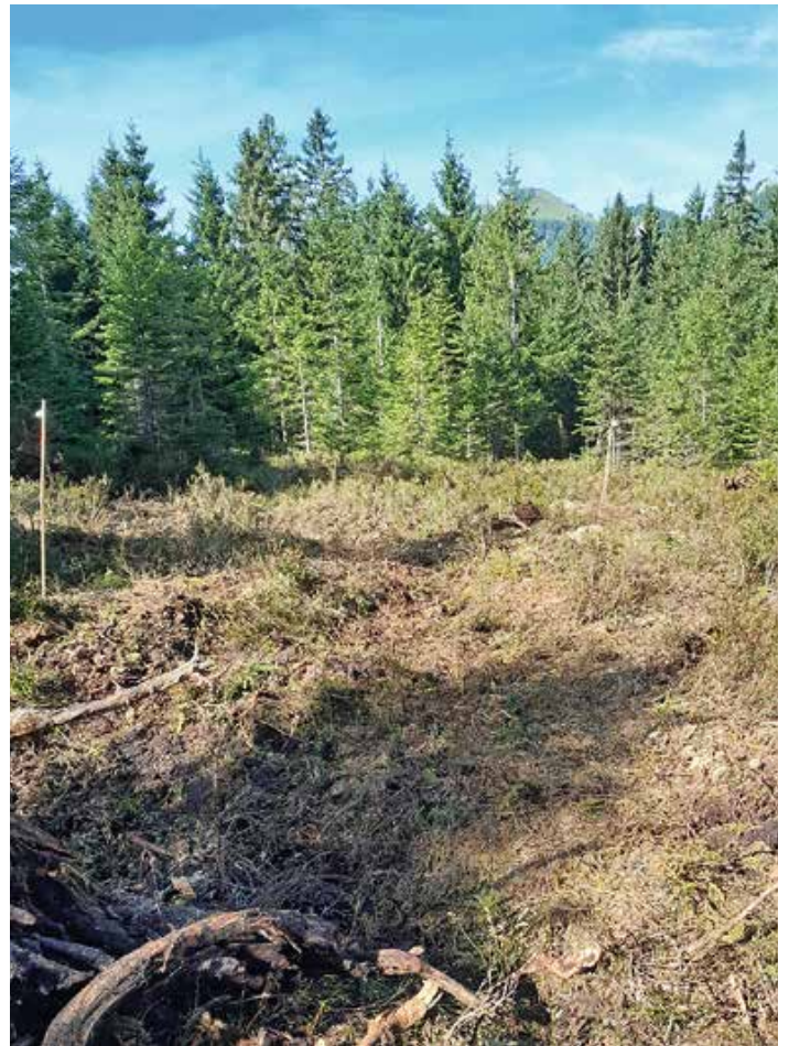
Fertige Dämme Kleinmoore Sybelle.
