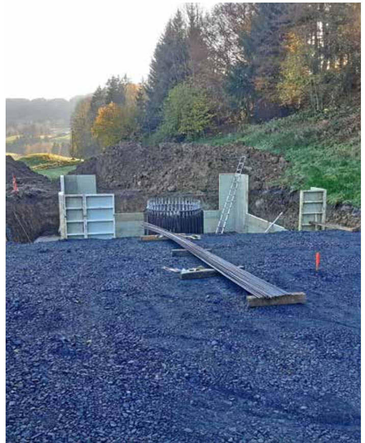
Die Bauarbeiten des neu entstehenden Mobilfunkmast in Vorderburg (Bereich Langasse) haben begonnen. Foto: Helmut Roth
