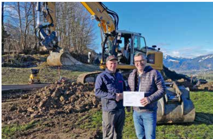
Von links: Tiefbauunternehmer Tobias Mägdefrau (Erdarbeiten) und Erster Bürgermeister Nikolaus Weißinger. Foto: Alois Moosbrugger, Wasserwart
