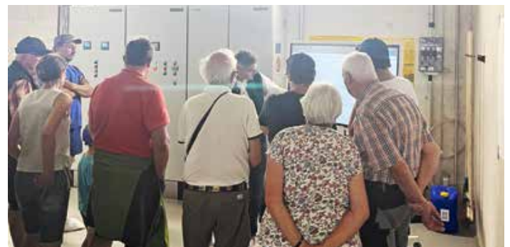
Führung des Wasserwarts im neuen Hochbehälter.
