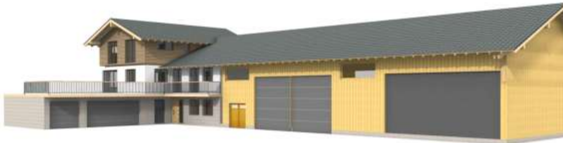
Abbildung 9 Umsetzungsbeispiel: Ansicht aus Südost. Planung: Schweiger Bau, Rettenberg.
