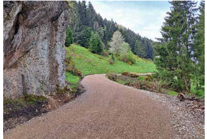
Die neue „Alte Salzstraße“ bei Rottach mit fertiggestellter Deckschicht ist wieder freigegeben. Foto: AELF – Martin Wenzel
